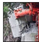
制震ダンパー取付部の損傷
