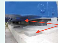
支保交換が容易な構造の例
