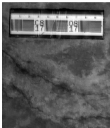
本技術を使用し時速 100kmで 走行しながら撮影したトンネル表面の画像
