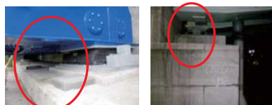
ジャッキアップに配慮した構造
