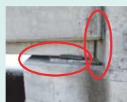
支保交換や桁端点検の空間なし
