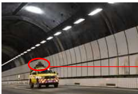
トンネル内の撮影状況
