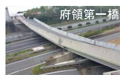
ロッキング橋脚を有する橋の落橋
