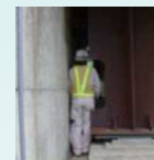
支保交換や桁端点検の空間なし
