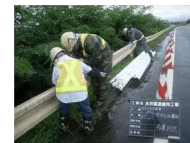
< 防護柵の取替 >
