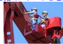
直轄診断(三島大橋)
