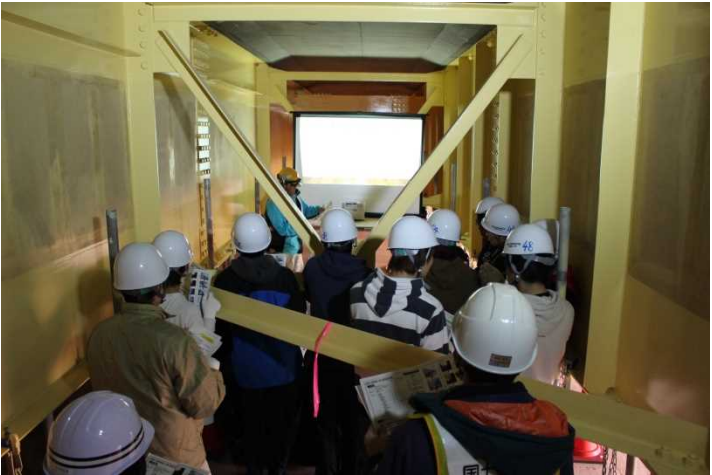
補修工事の見学会(11月10日)
