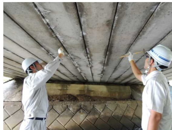
橋梁点検診断研修(9/29 石川県)
