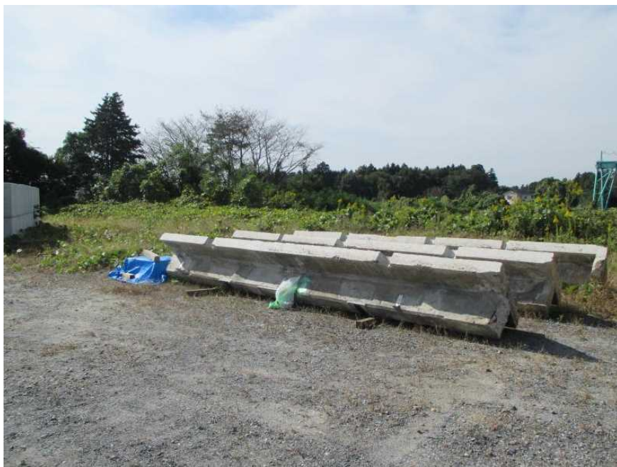
土木研究所内（つくば）に仮置き中の「五幅4号橋」
