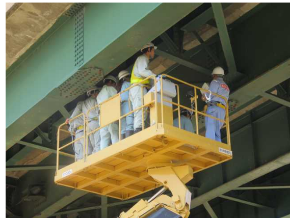
5月20日橋梁初級Ⅰ(西部)点検実習
