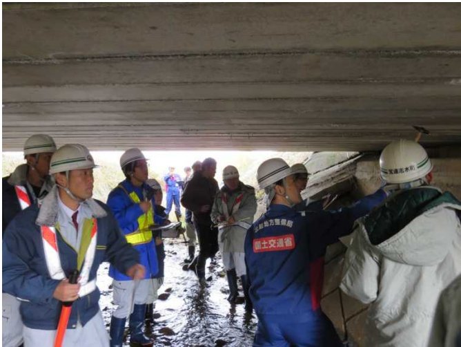
自治体管理橋梁で自治体職員自ら点検 (11月20日 石川県宝達志水町)
