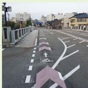
自転車走行指導帯 設置後
