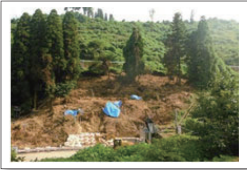
土砂崩れ (安楽寺地区 平成25年8月1日発生)
