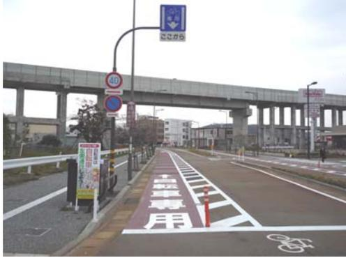
▼道路標識「普通自転車専用通行帯(327の4の2)」と道路標示「専用通行帯（109の6）」を設置した事例（金沢市）
