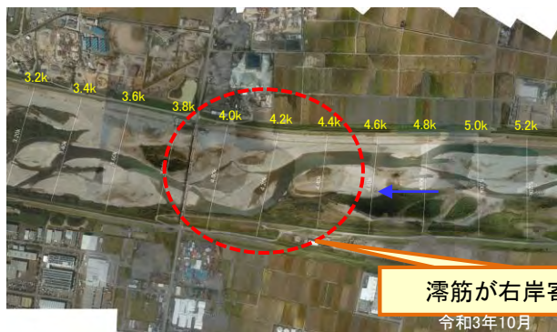
滞筋が変化した主な箇所(左岸4.0～4.4k付近)
