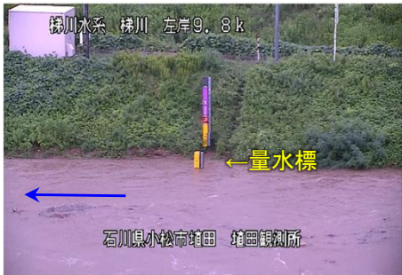
埴田水位観測所の流下状況（CCTV画像） （河口より9.8k付近：30日7時10頃）
