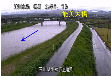
能美大橋付近の流下状況（CCTV画像） （河口より6.7k付近：30日7時50頃）
