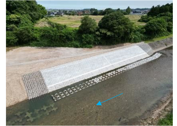
災害復旧工事 R5完了(小松市古府地先)
