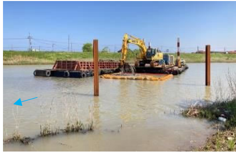
河道掘削工事 R4完了 (小松市下牧町～丸内町地先)
