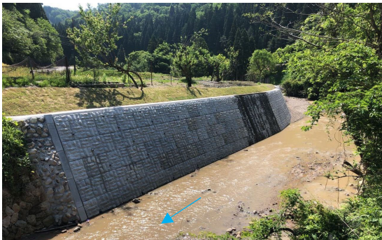
災害復旧工事 R5完了(小松市上麦口町地先)
