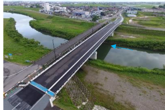
橋梁架替工事 R5新橋完了(能美大橋)
