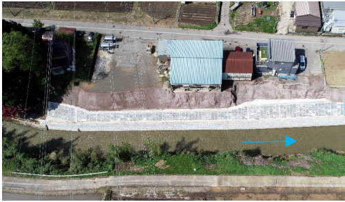
災害復旧工事 R5完了(小松市岩湊町地先)
