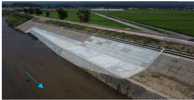
災害復旧工事 R5完了(小松市古府町地先)
