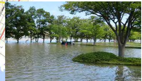
西園地駐車場の浸水状況(令和4年8月5日11時30分頃)
