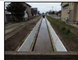
九竜橋川排水路の整備 (小松市打越町地内)
