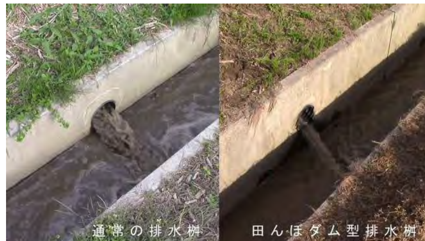
調整板の設置前/設置後
