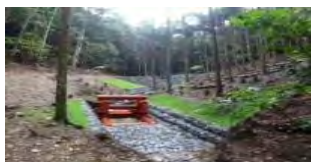
簡易流木防止施設の設置
