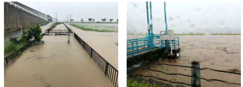
軽海放水路:八幡 (令和4年8月4日撮影)
