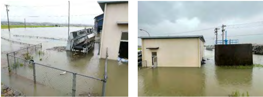
白江排水機場 (令和4年8月4日撮影)
