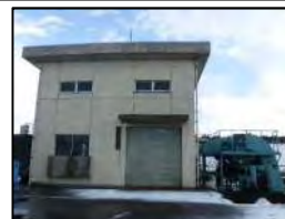
園排水機のオーバーホール (小松市園町地内)
