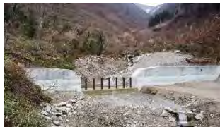
治山ダム背面の土砂撤去
