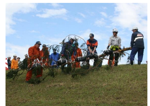
木流し工実施状況
