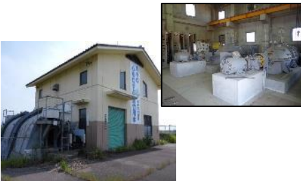
佐野排水機場の整備 (能美市佐野町地内)
