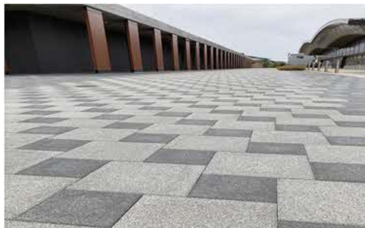
能美ふるさとミュージアム 保水・透水性インターロッキングブロック
