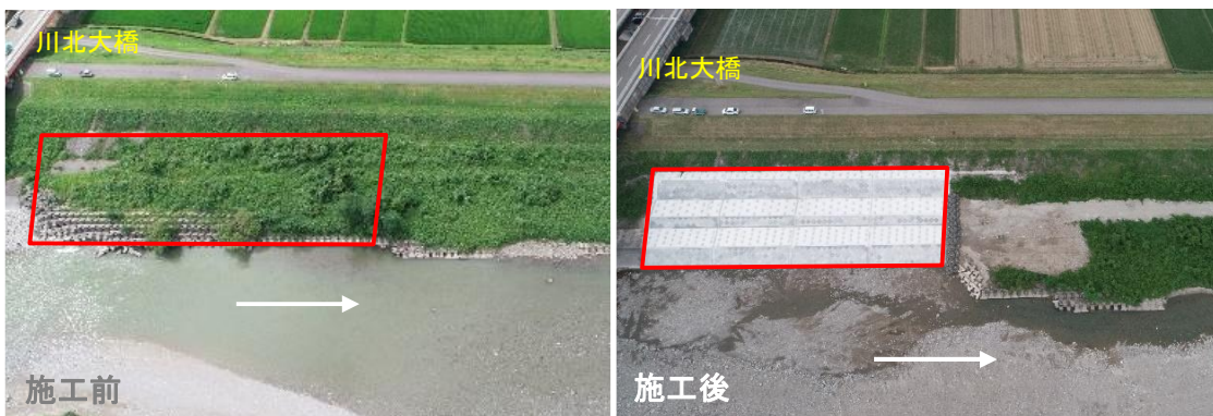
急流河川対策(根継護岸)：能美市三ツ口地区(R3年度)
