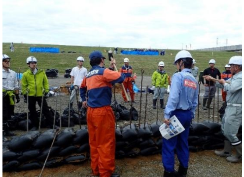
積み土のう工実施状況
