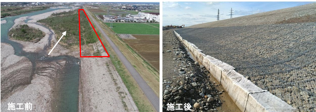
急流河川対策(前腹付盛土)：川北町三反田地区(R6年度)
