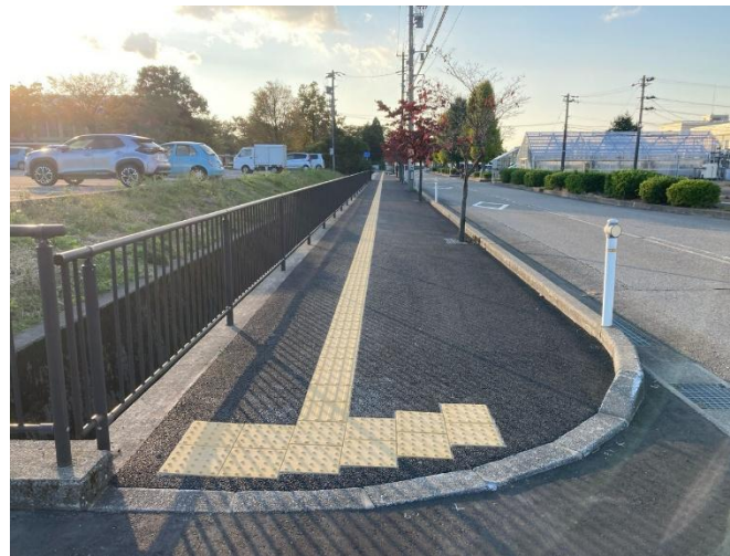
額谷末松線 舗装復旧工事（令和6年度 施工） 事業延長 L=530m、歩道幅員 W=3.5~5.0m 事業概要 開粒度アスコン A=1,382㎡
