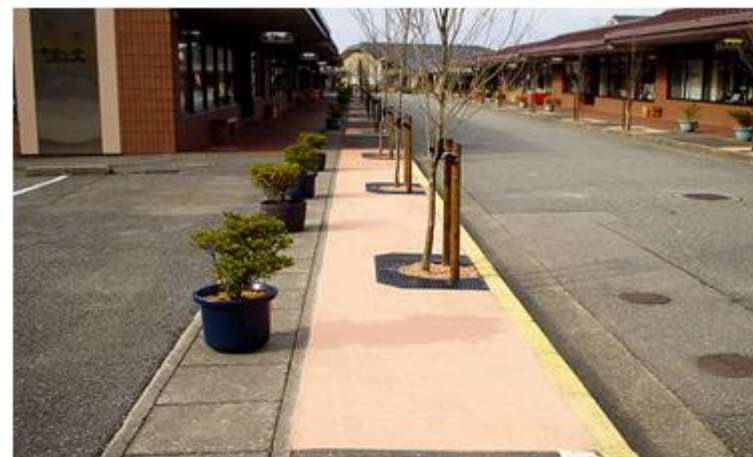
九谷陶芸村 瓦廃材利用保水性舗装
