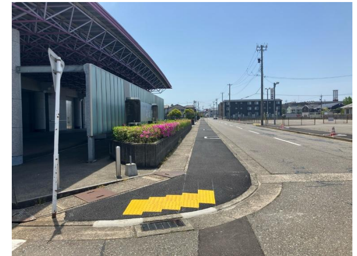
矢作西線 歩道改良工事（令和6年度 施工） 事業延長 L=470m、歩道幅員 W=2.5m 事業概要 開粒度アスコン A=773㎡
