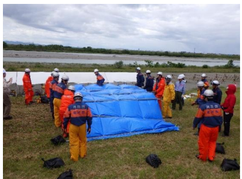
シート張り工実施状況
