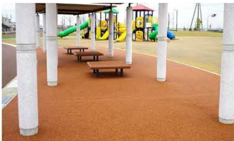
福島親水公園 瓦廃材利用透水性樹脂舗装
