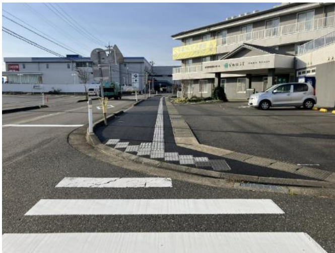
二日市徳用線 歩道修繕工事（令和6年度 施工） 事業延長 L=60m、歩道幅員 W=3.5m 事業概要 開粒度アスコン A=131㎡
