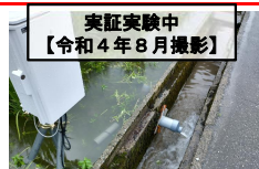
排水口の径φ100をφ50に絞り、排水を抑制
