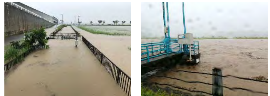
軽海放水路:八幡 (令和4年8月4日撮影)
