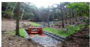
簡易流木防止施設の設置
