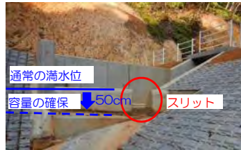
洪水吐スリットを設置したため池 (小松市正蓮寺町)
