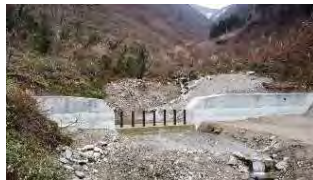
治山ダム背面の土砂撤去
