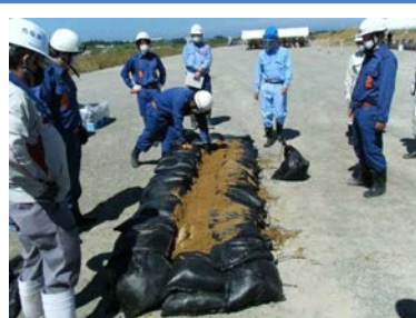
積み土のう工実施状況
