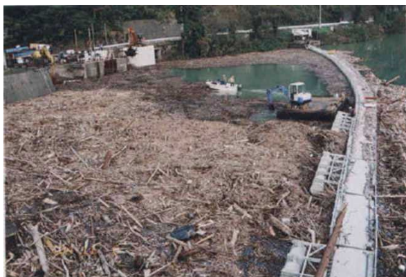
北陸電力(株) 神二ダム
