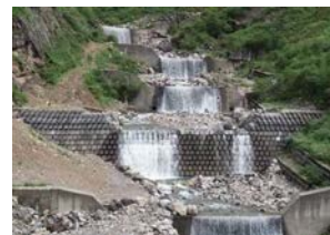
【治山：溪間工】 (コンクリートブロックえん堤)
