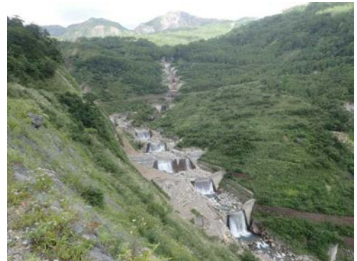
【湯の谷上流部】
