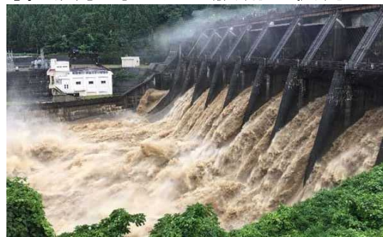
北陸電力(株) 神二ダム
