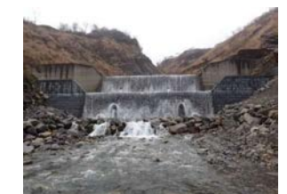
【治山：溪間工(谷止工)】
