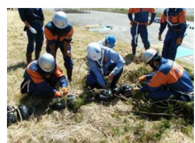
木流し工実施状況
