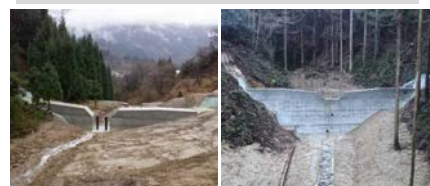
治山ダムによる流木・土砂流出発生の防止
