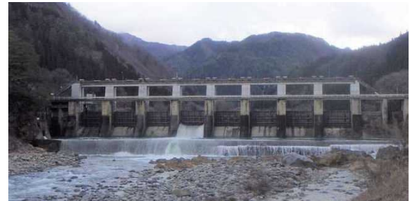
北陸電力(株) 浅井田ダム
