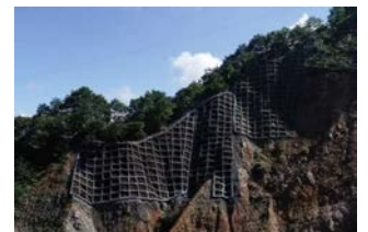
【治山：山腹工(簡易法枠工)】
