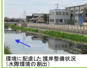
環境に配慮した護岸整備状況(水際環境の創出)
