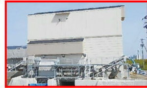
排水ポンプ場増強（小松市）
