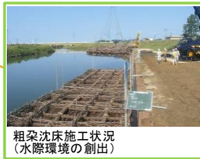
粗朶沈床施工状況(水際環境の創出)
