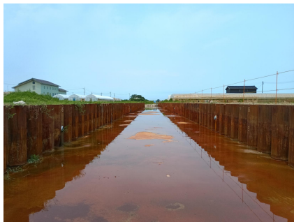
矢板打設状況
