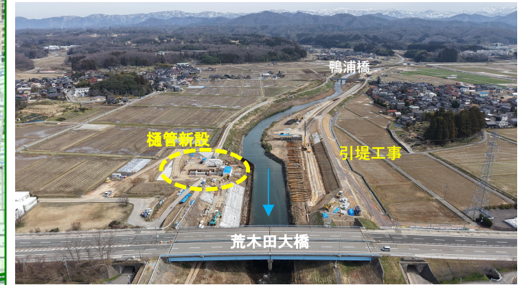
堤防整備工事 施工中 (荒木田大橋付近)
