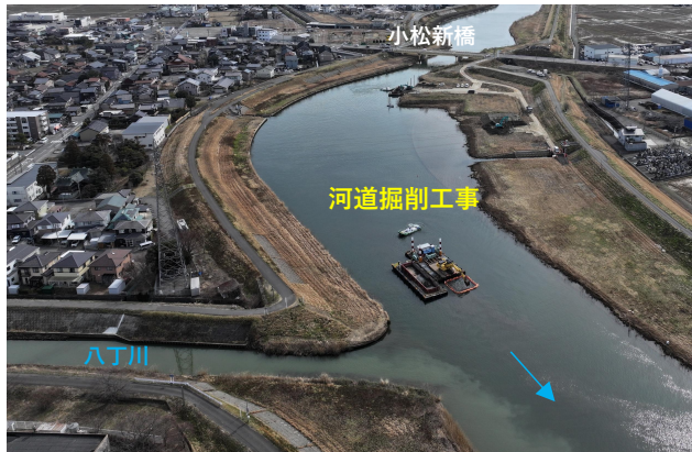
河道掘削工事 施工中 (梯大橋～小松新橋)
