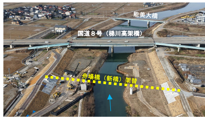
橋梁改築工事 施工中 (千代町地先)
