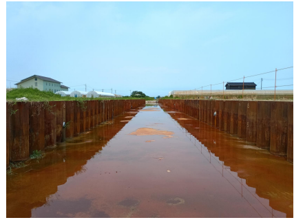
矢板打設状況
