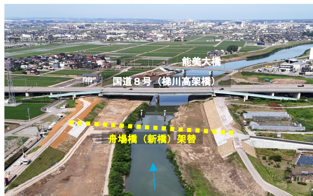
橋梁改築工事 施工中(千代町地先)
