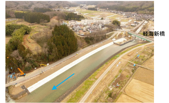
災害復旧工事 R5施工中(遊泉寺地先)
