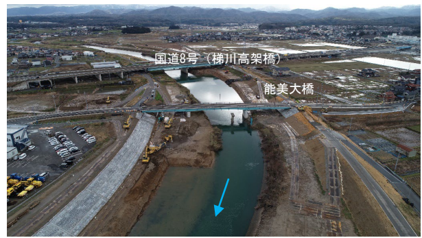
堤防整備工事 R5施工中(能美大橋付近)
