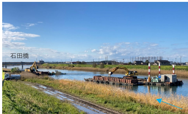
河道掘削工事 R5施工中(小松市丸内町)
