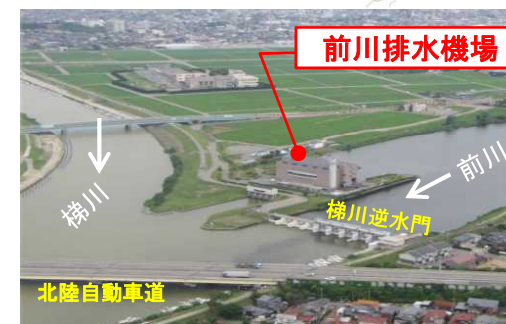
前川排水機場
