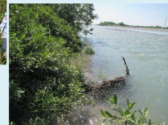
「かご工」破損、 詰石流失の状況
