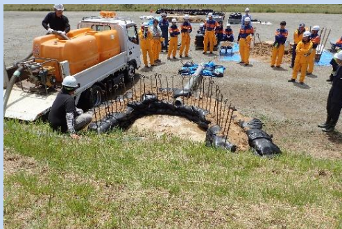
工法実技(月の輪工)
