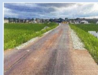
舗装のない通路の鉄板設置状況
