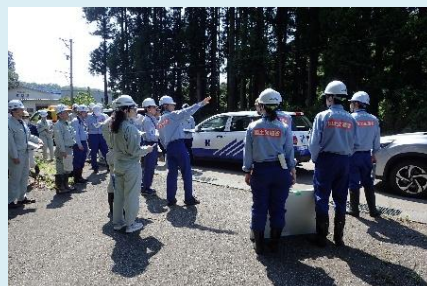
R12.0kp付近 越水(溢水)箇所
