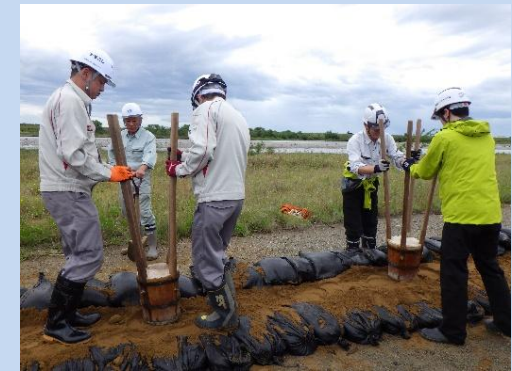
工法実技(積み土のう工)
