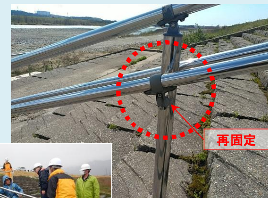
手すりを 固定し直し
