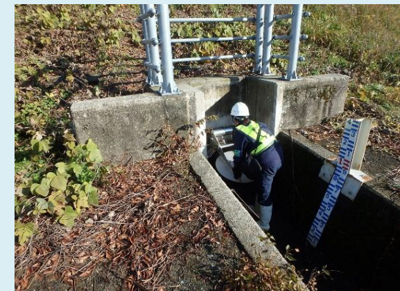
目的別巡視（水門・樋管点検）
