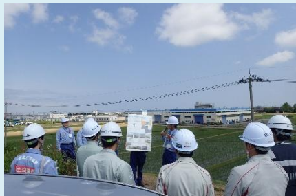
R9.6kp付近 基礎地盤漏水箇所
