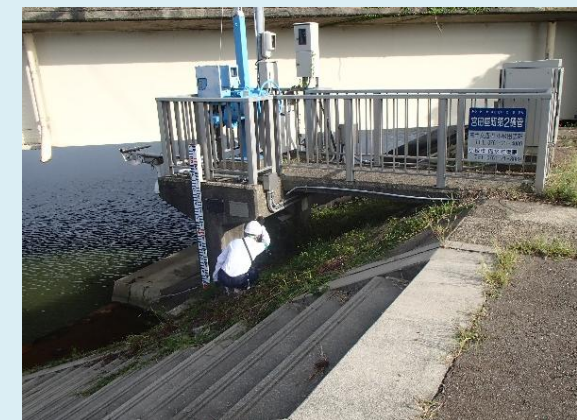
目的別巡視（水門・樋管点検）
