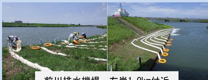
前川排水機場 左岸1.0km付近
