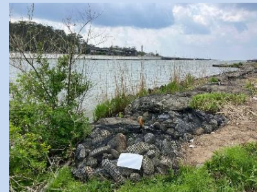
袋詰玉石で補修
