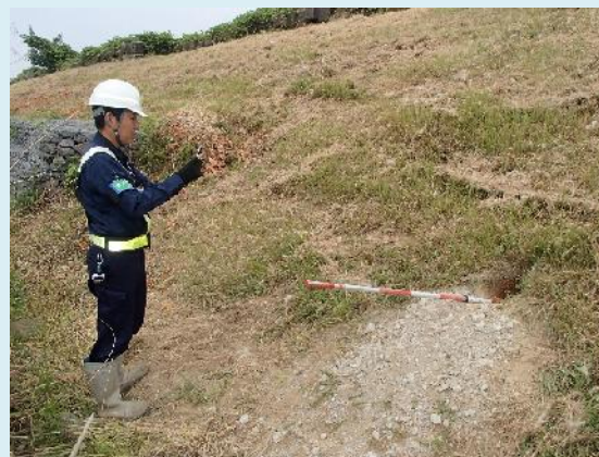
目的別巡視（堤防等点検）
