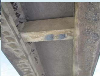
管理橋コンクリート桁の損傷
