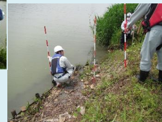
覆われていたブロック マットが露出している
