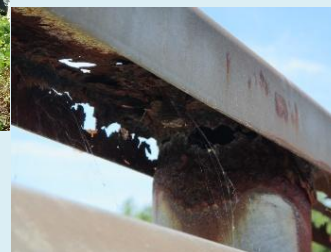
高欄の腐食状況
