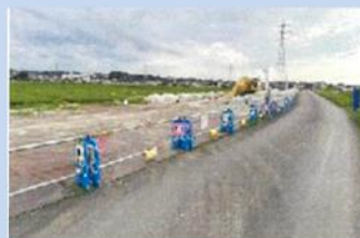
工事範囲と通行範囲の区分状況
