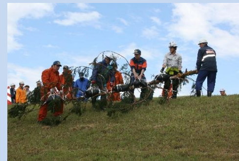
工法実技(木流し工)
