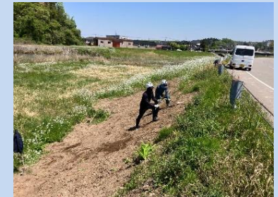
修繕作業（人力）
