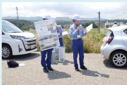
L9.0kp付近 堤体漏水箇所
