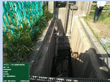
開閉装置機能検査
