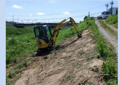
修繕作業（機械）
