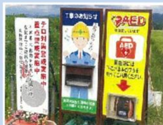
工事の案内看板設置状況
