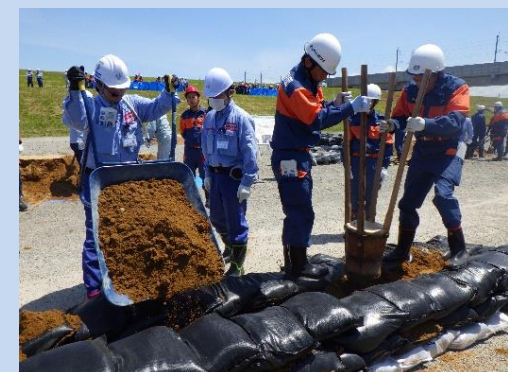
工法実技(積み土のう工)
