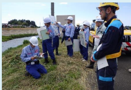
R10.0kp+70～150m 越水箇所
