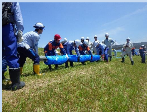
工法実技(シート張り工)
