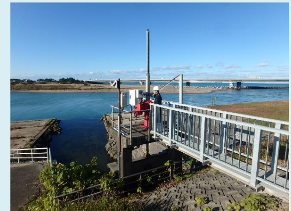
目的別巡視（水門・樋管点検）
