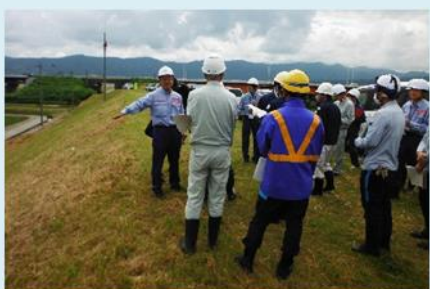
R9.6kp付近 基礎地盤漏水箇所
