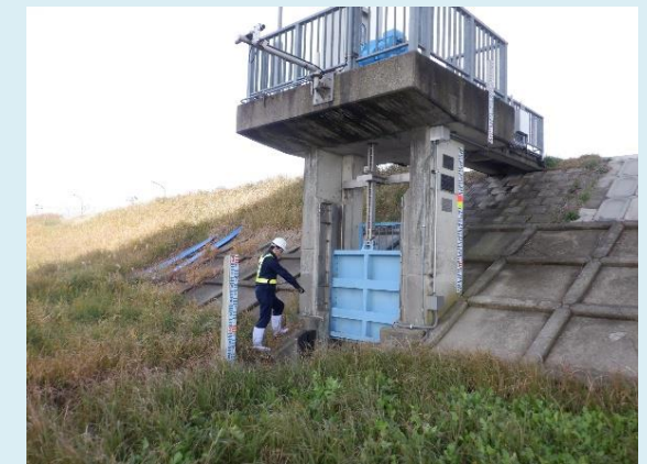
目的別巡視（水門・樋管点検）
