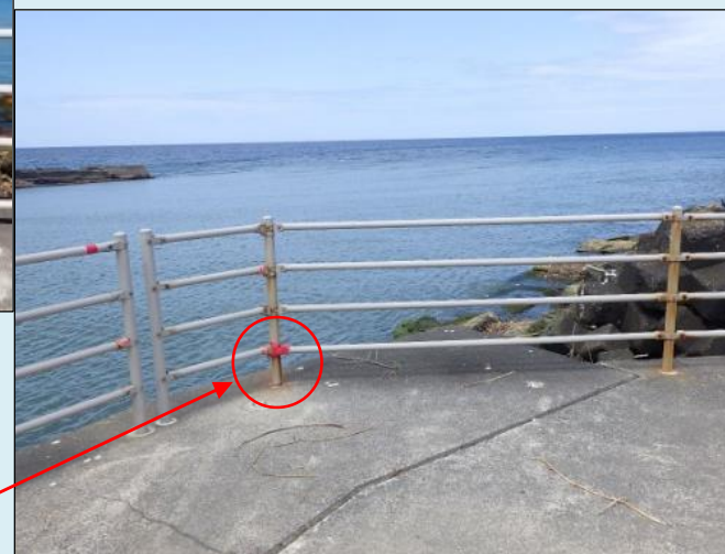
ゴールデンウィーク前 導流堤(右岸)の点検 (手取川 R-0.2k付近)
