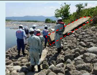
急流河川対策 盛土の侵食拡大を確認
