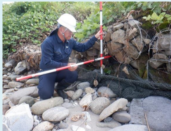
目的別巡視（堤防等点検）
