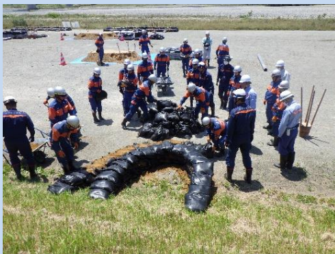
工法実技(月の輪工)
