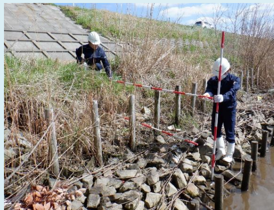
目的別巡視（堤防等点検）
