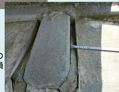
条件護岸の 沈下と破損
