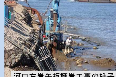
河口左岸矢板護岸工事の様子
