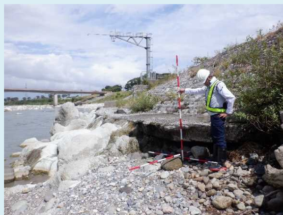
目的別巡視(堤防等点検)
