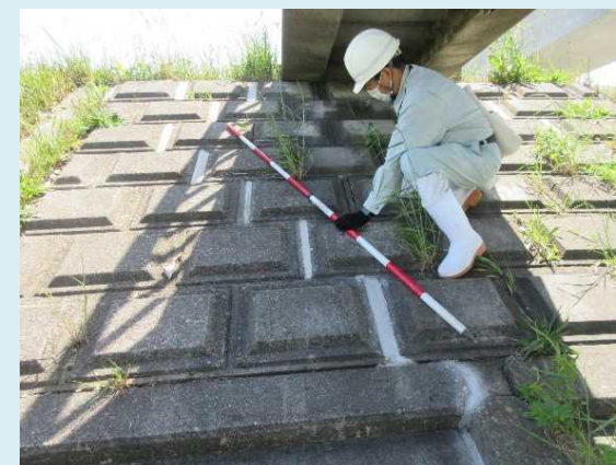
目的別巡視(水門・樋管点検)
