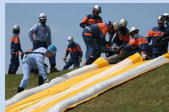
工法実技(水防マット工)
