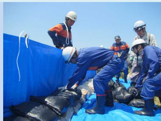
工法実技(改良積み土のう工)
