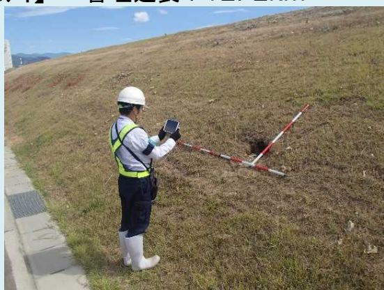
一般巡視(定期パトロール)
