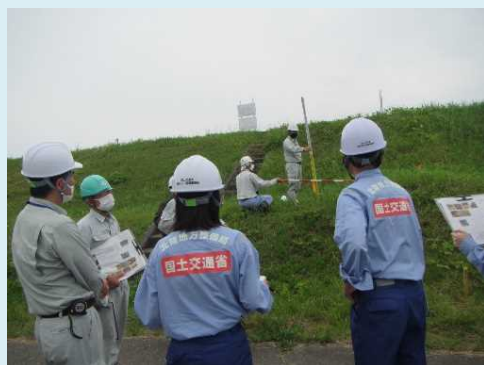
左岸0.8kp+10m 梯川右岸第一樋管の抜け上がりを確認
