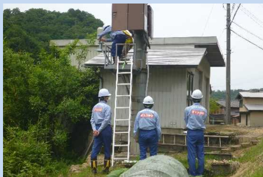
鍋谷雨量観測所
