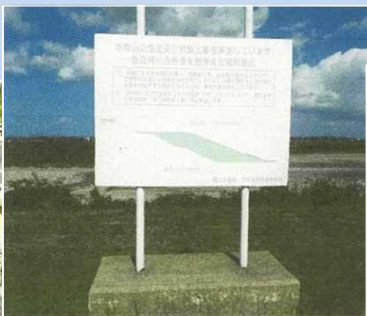
看板の表示が劣化して読みにくい
