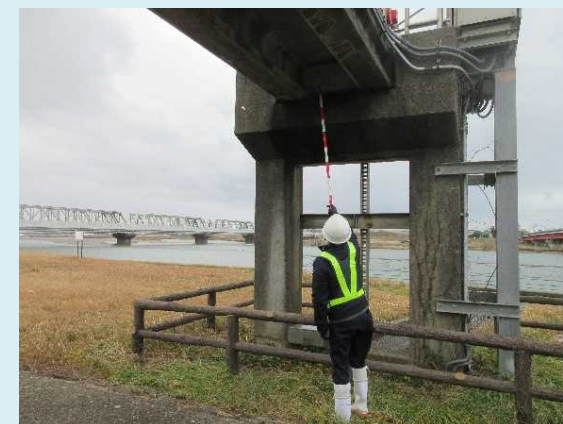
目的別巡視(水門・樋管点検)
