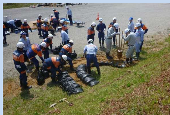
工法実技(月の輪工)
