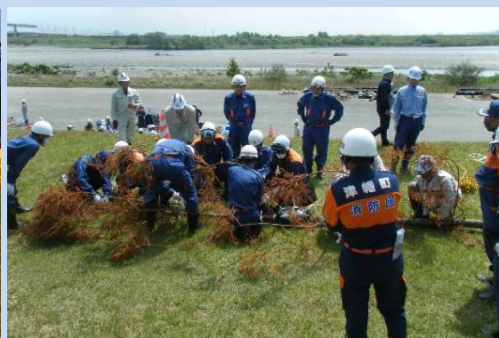
工法実技(木流し工)
