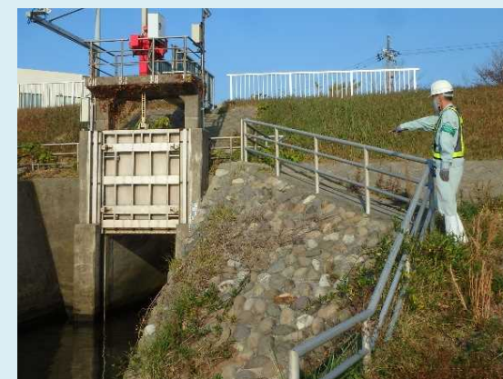
目的別巡視（水門・樋管点検）
