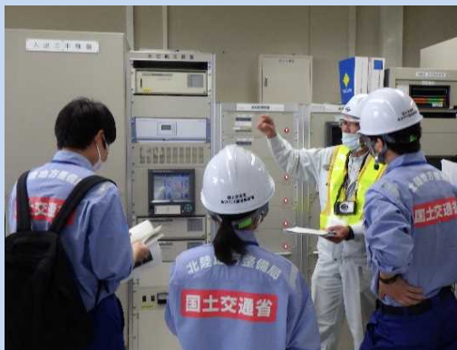
梯川逆水門水位観測所点検状況
