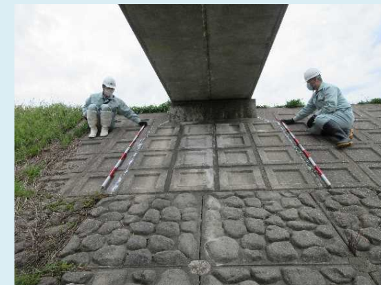
目的別巡視（水門・樋管点検）
