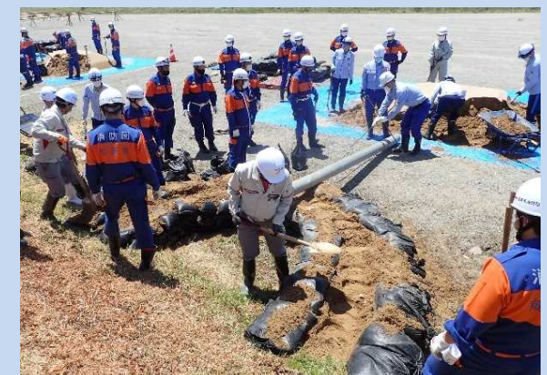
工法実技(月の輪工)
