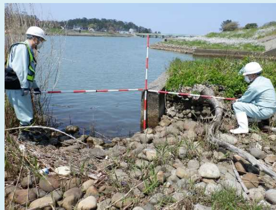
目的別巡視（堤防等点検）
