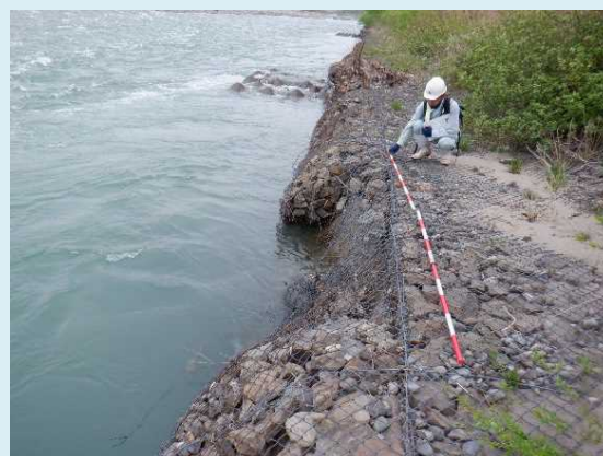
目的別巡視（河岸状況等点検）
