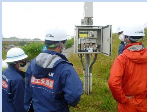
西川合流点水位観測所点検状況
