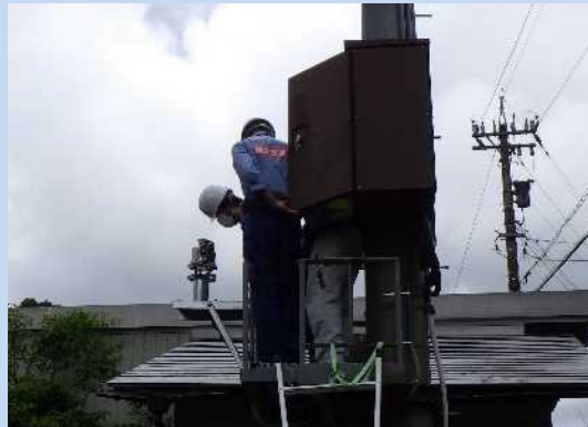
鍋谷雨量観測所点検状況
