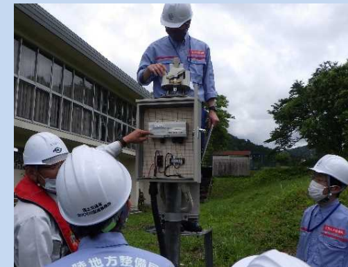
波佐羅雨量観測所点検状況
