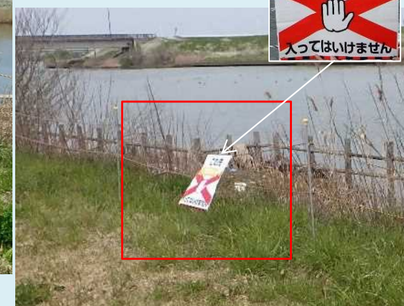
丸内低水護岸の点検（梯川左岸2.4k付近）
