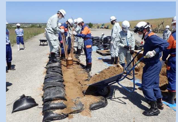
工法実技(積み土のう工)
