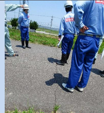
右岸11.0km-80m付近 堤防天端As舗装に横断方向クラック
