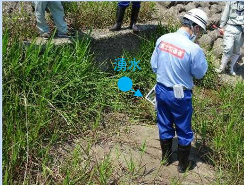
左岸13.2km+15m 低水護岸基礎下面水抜き穴より大量の湧水を確認
