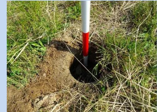
左岸6.0km+60m 矢板護岸笠コンクリート背面に吸い出し穴(補修済み箇所が吸い出し)
