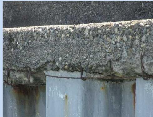
右岸-0.15km+30m付近 笠コンクリート前面の破損、鉄筋露出(L=19.3m)
