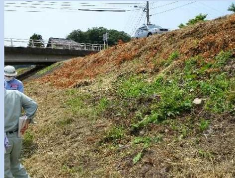
左岸11.0km+40m 川表法面にイノシシによる損傷
