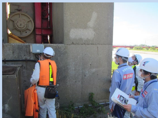
美川水門水位計点検状況
