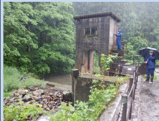
下田原取水ダム （白山市下田原）点検
