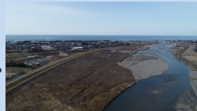
伐採後(左岸1.6km付近)
