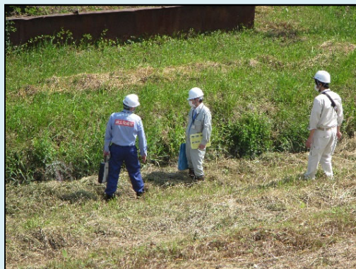
手取川R3.0k～3.2k 基礎地盤漏水B
