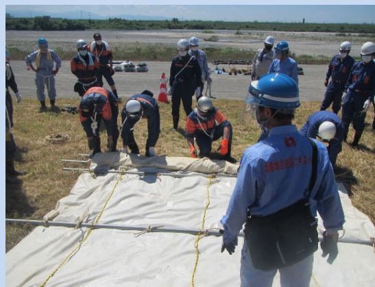
工法実技(シート張り工)
