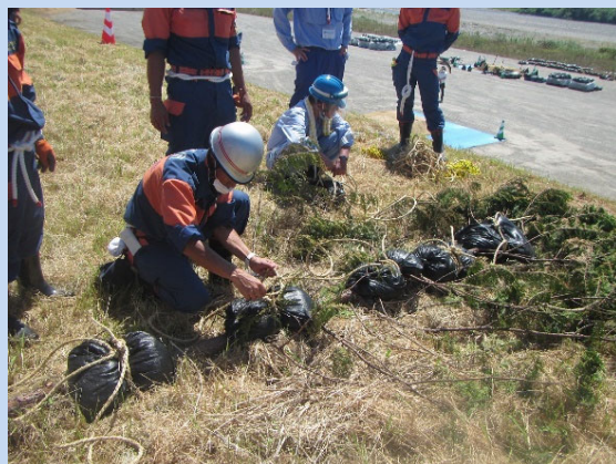
工法実技(木流し工)
