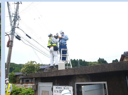
中海雨量観測所点検状況
