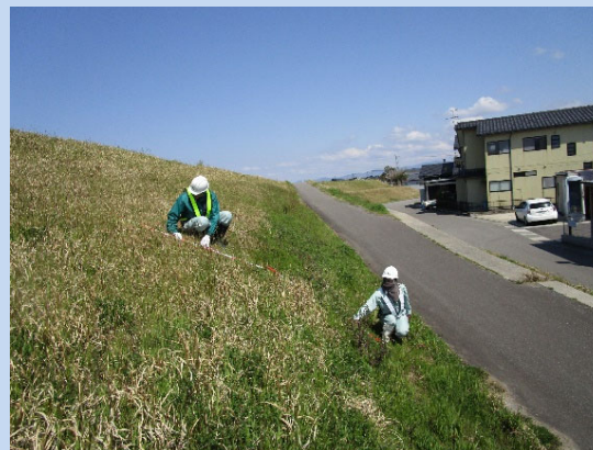
目的別巡視（堤防等点検）
