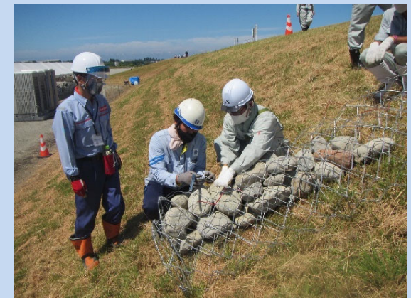
工法実技(蛇かご工)
