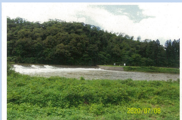
R2.7(梯川)降雨後の水位
