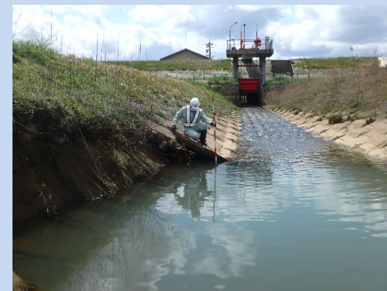
目的別巡視（水門・樋管点検）
