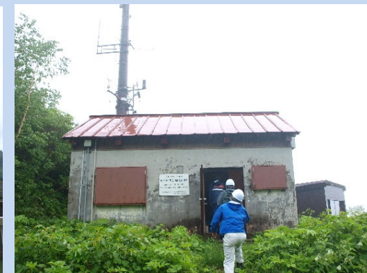
甚之助雨量観測所点検状況
