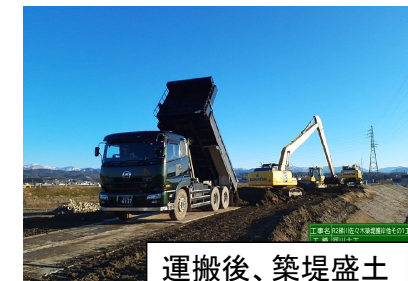
曝気・粒度調整後、積込、土砂運搬
