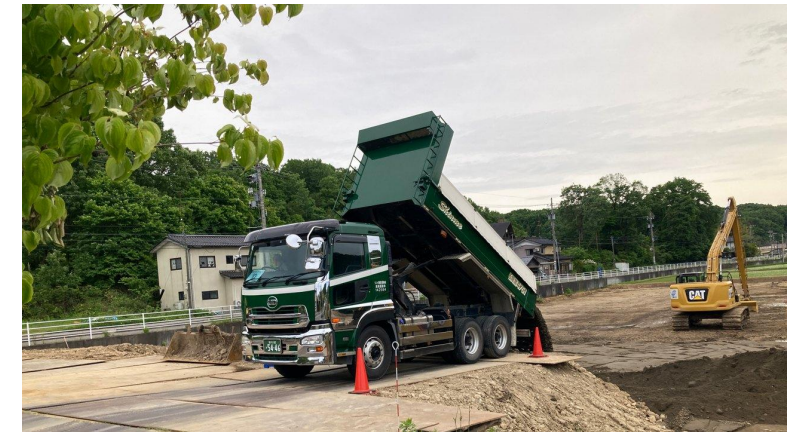
国工事で河道掘削土砂の運搬を実施（図2-16）
