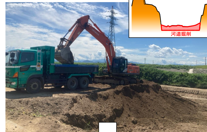
①河道掘削土砂を曝気し、 ダンプトラックへ積み込み
