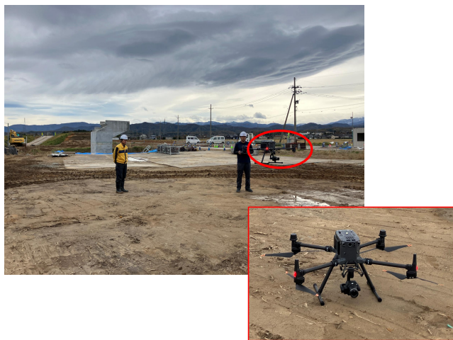
①ドローンを活用した3次元起工測量
