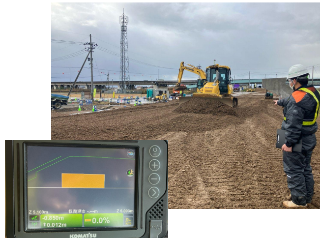
③マシンコントロールブルドーザによる盛土敷均し
