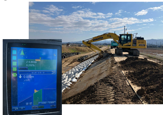
④マシンコントロールバックホウによる法面整形
