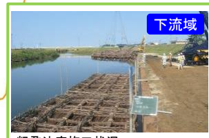
粗朶沈床施工状況(水際環境の創出)
