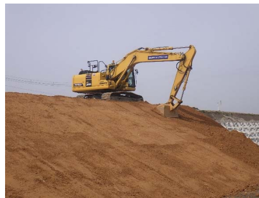
ICT建機による法面整形 ※バケットの刃先が設計面に達すると機械が自動制御
