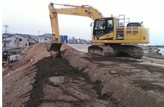
河道掘削土砂を堤防拡幅・築堤の盛土材として有効活用（図6-1）
