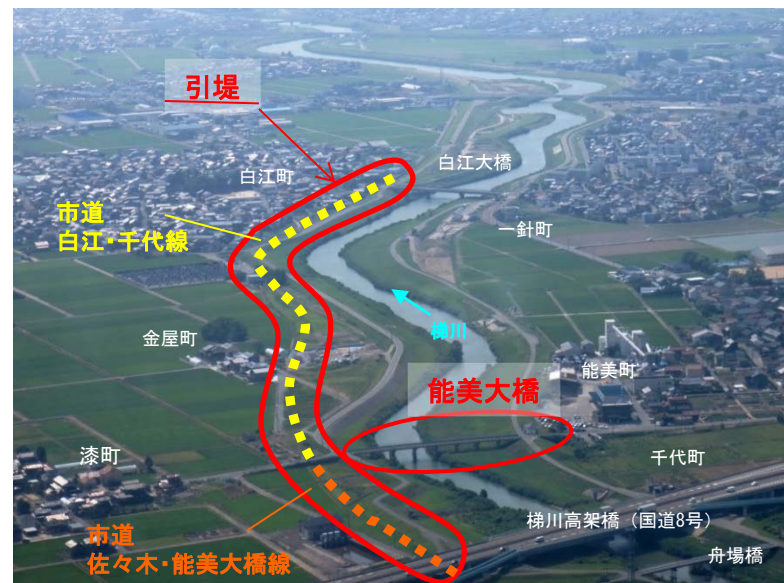
道路事業と一体となった河川改修（図7-3）
