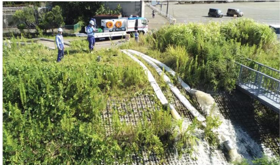
▼排水作業の状況
