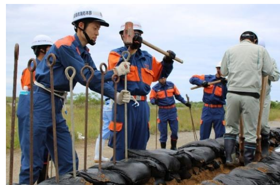
積み土のう工
