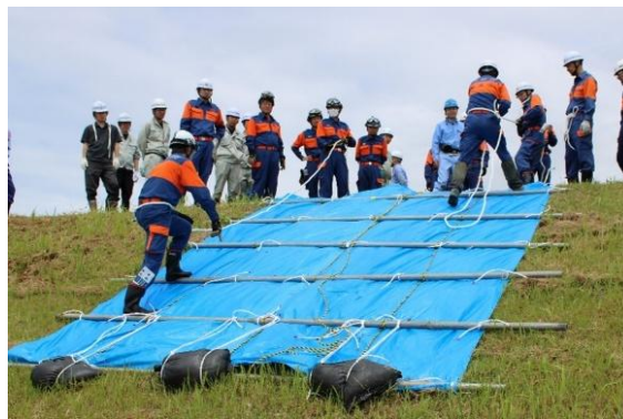
シート張り工
