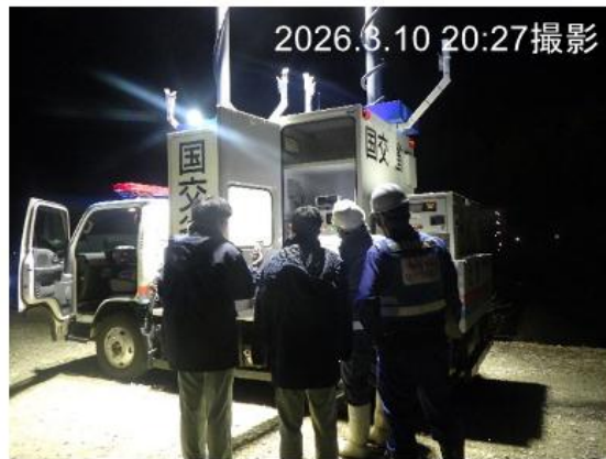
照明車操作状況
