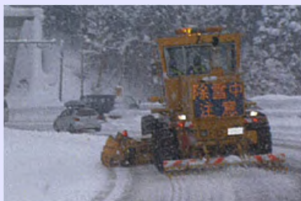
路面整正作業状況
