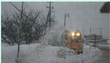
歩道除雪作業状況
