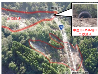
(大雨被災状況 R6. 9)
