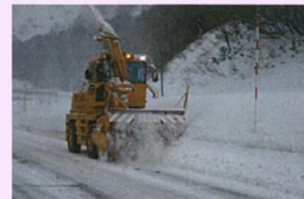
拡幅除雪作業状況
