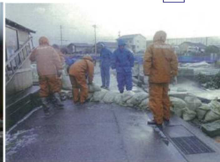
H26.12.2 午後 水防団による土のう積み(右側が水防団による土のう積み直し後)
