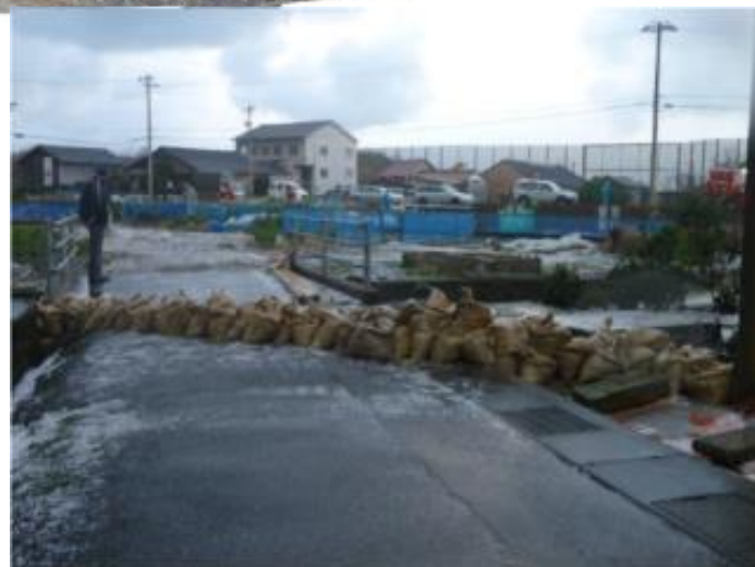
H26.12.2 午後 水防団による土のう積み(右側が水防団による土のう積み直し後)
