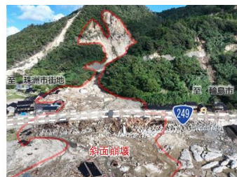
(大雨被災状況 R6. 9)
