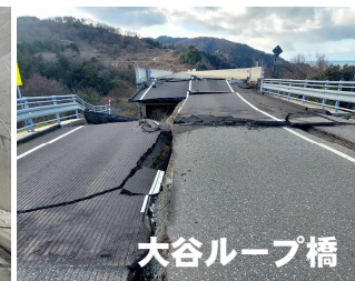
⑤大谷トンネル・ループ橋工区 (地震被災状況)
