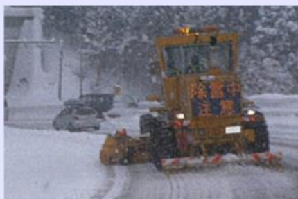
路面整正作業状況
