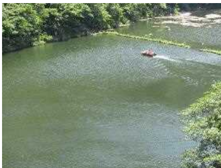
【①点検整備基準に基づく設備点検】 ダム貯水池周辺斜面等の巡視状況
