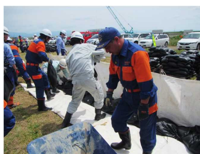
改良積み土のう工の実技
