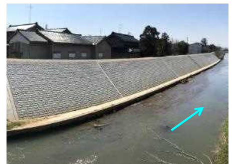
【堤防補強実施箇所】 八丁川 河原橋下流(小松市長田町)
