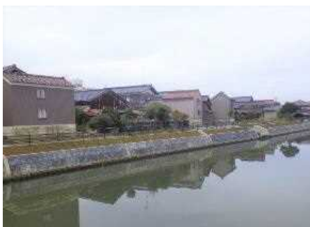
【河川改修実施箇所】 前川 御幸橋上流 (小松市今江町)
