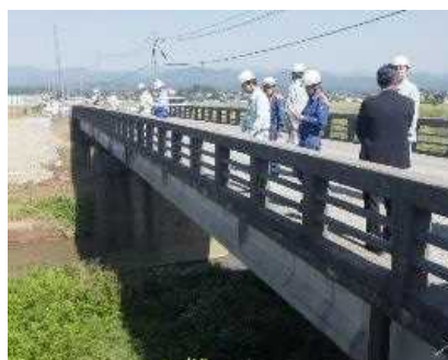
【南加賀土木 重要水防箇所】 鍋谷川 (能美市千代町)
