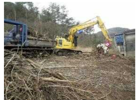
【③維持修繕工事の実施】 ダム貯水地内流木の除去状況
