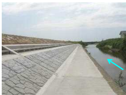
【堤防補強実施箇所】 鍋谷川 鍋谷川橋上流(小松市古府町)
