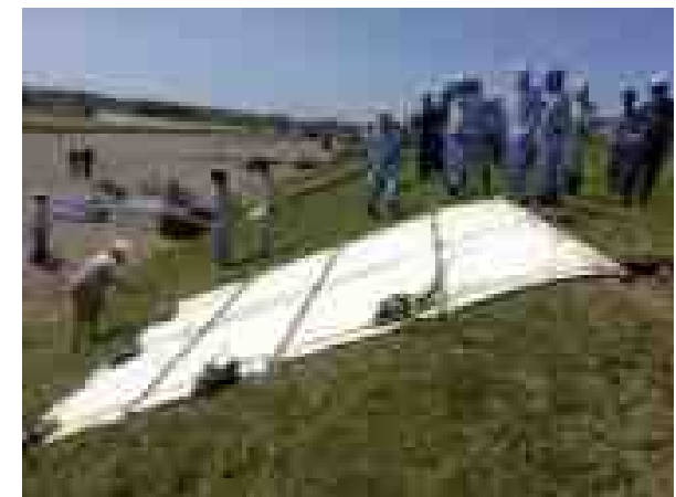
シート張り工
