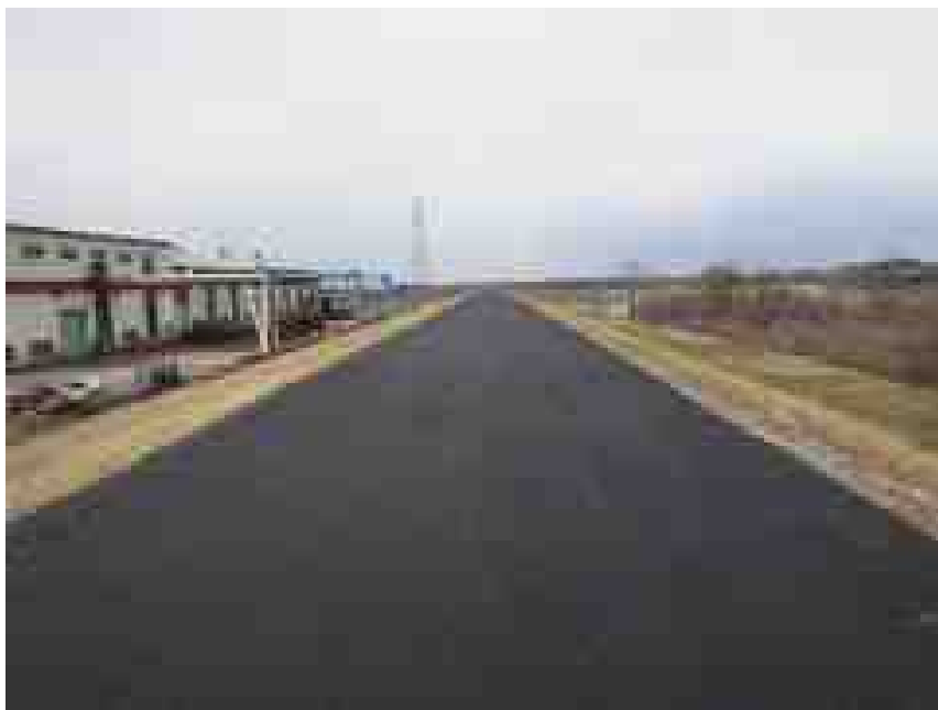
天端保護(手取川 左岸12.0k付近)
