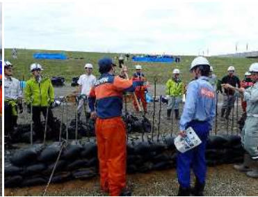
積み土のう工の実技
