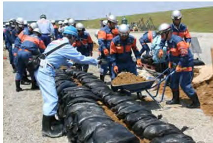
積み土のう工の実技
