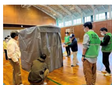
【組立トイレ設置】
