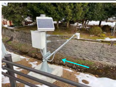
危機管理型水位計設置写真(粟津川)
