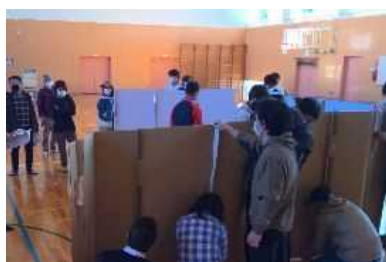
段ボール間仕切りの設置
