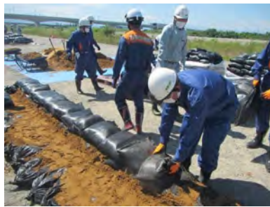
積み土のう工の実技
