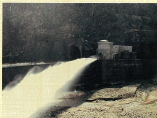
維持流量放流設備
