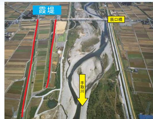
★平面的に不連続な堤防「霞堤」は、破堤した場合に次の堤防でその流れを食い止めます。
