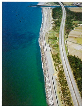
片山津工区(撮影:平成17年)
