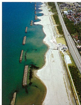
根上工区(撮影:平成17年)
