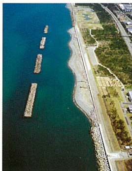
小松工区(撮影:平成17年)
