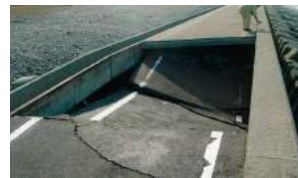
◀片山津工区 天端陥没状況 平成19年11月 低気圧による
