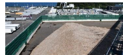
フェンス設置により木材チップの飛散を防止
