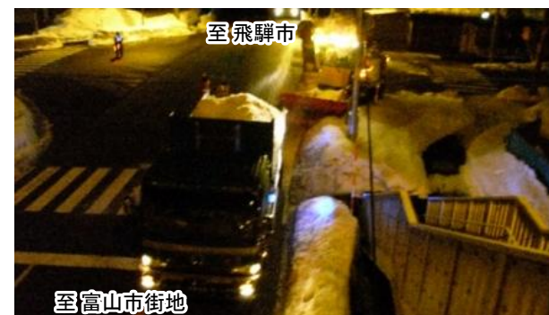
写真4-5 路肩確保のための運搬排雪作業
