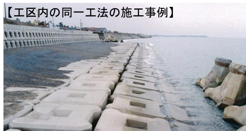
写真2-1 小松工区における根固消波工の施工事例(県)
