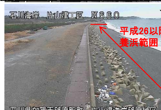
図2-2 片山津工区事業実施状況 (養浜工、根固工)
