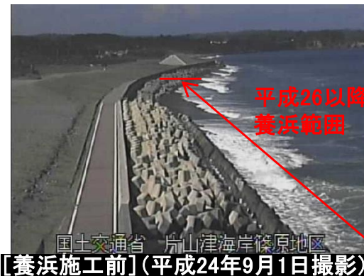
図2-1 小松工区の事業実施状況(人工リーフ全15基完成、養浜工を実施中、今後根固消波工を整備)
