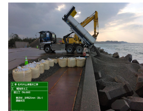
養浜施工状況
