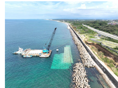
根固ブロック据付状況
