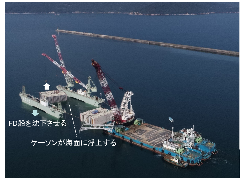
FD船を沈下させることでケーソンが浮上
