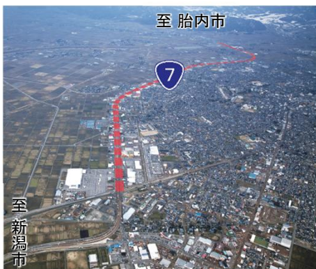
写真1-1 事業区間起点から 胎内市方向を望む
