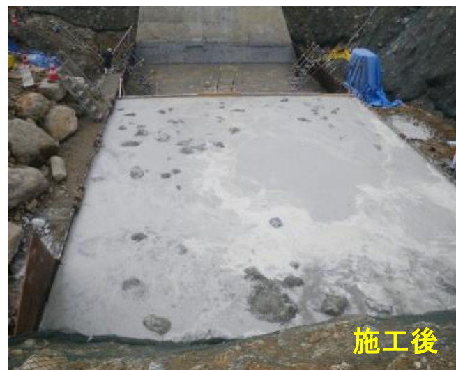
図4-10 新粗石コンクリート施工状況
