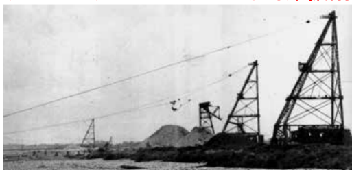
タワーエクスカータによる河床掘削
