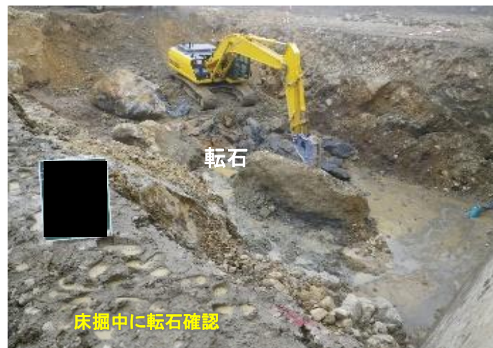
図4-4 ブレーカーによる転石破碎の追加
