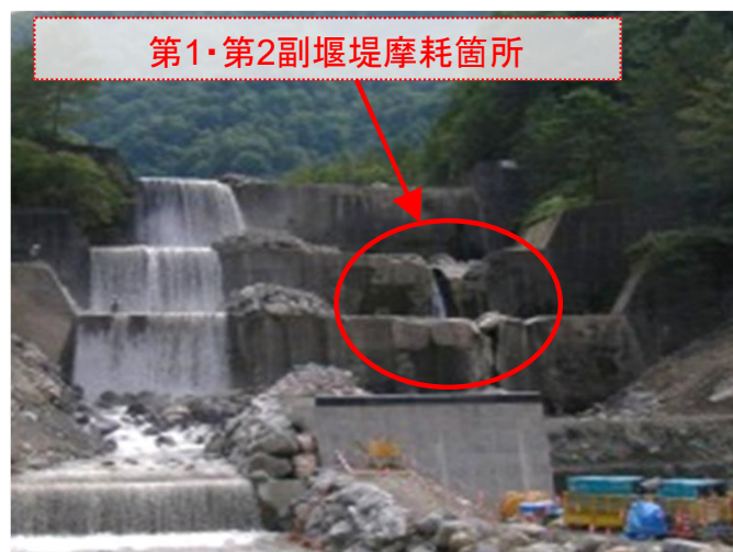
図4-6 砂防堰堤の改築(水谷第3号砂防堰堤)
