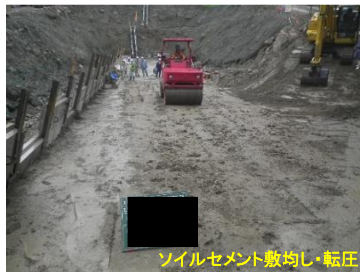
図4-11 砂防ソイルセメント施工状況
