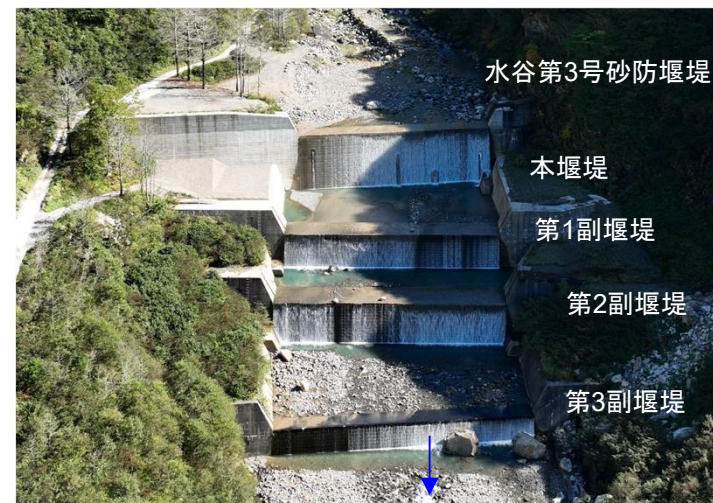
図4-6 砂防堰堤の改築(水谷第3号砂防堰堤)
