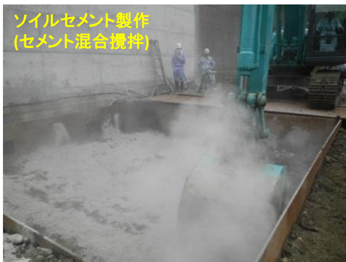
図4-11 砂防ソイルセメント施工状況
