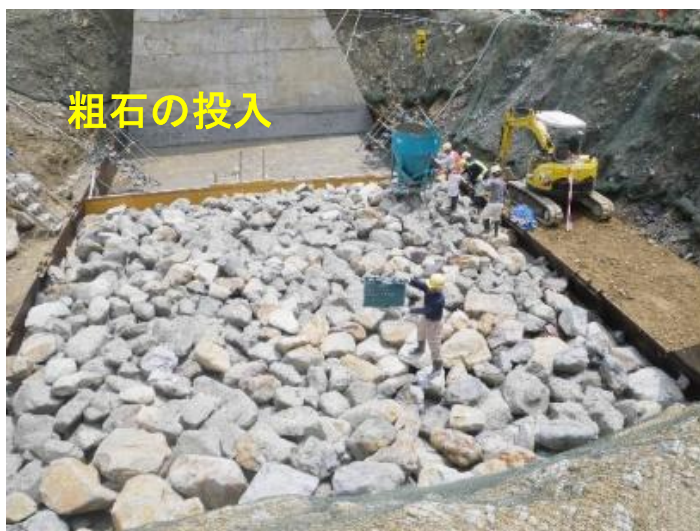
図4-10 新粗石コンクリート施工状況
