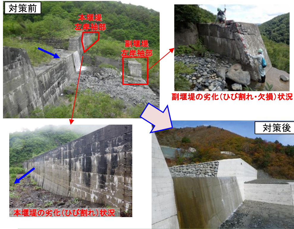
図4-6 堤体劣化に伴う補強対策の追加(崩沢下流第1号砂防堰堤)
