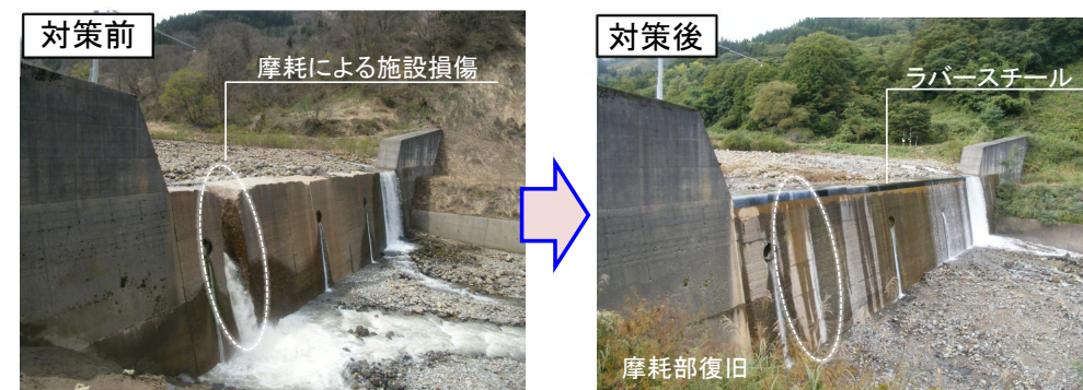
図4-4 天端摩耗対策の実施(浦川下流6号砂防堰堤)
