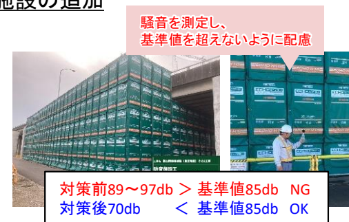
図3-6 橋梁下部工（防音施設工）
